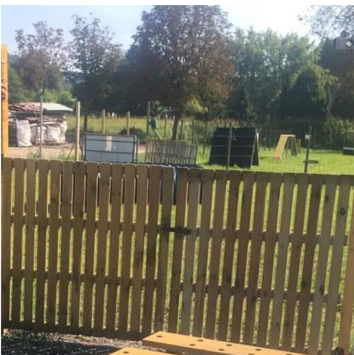
La pose de la porte
