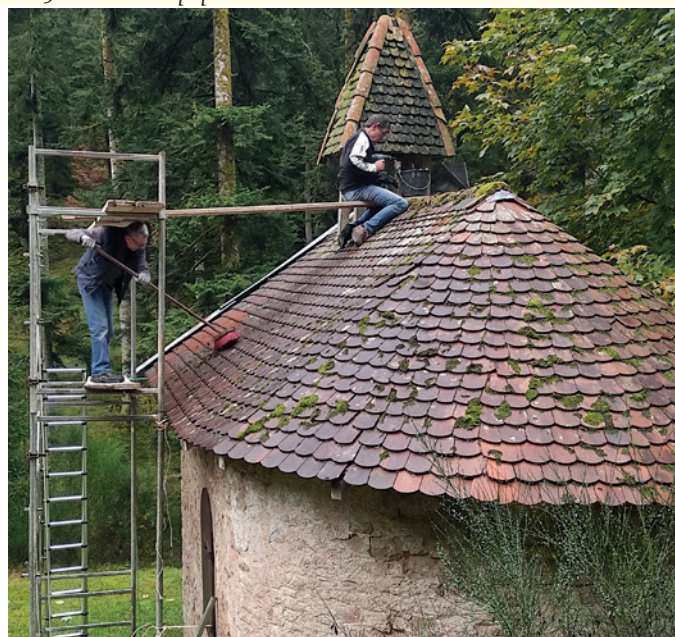
Chapelle de Ton : entretien du toit et remise en place d'une cloche
