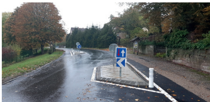
Modèle d'écluse qui sera mise en place (hors piste cyclable, faute de largeur suffisante).
