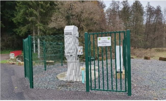
Poste situé rue Morval. Ce poste est équipé d'un dégrilleur automatique afin de trier les déchets provenant des collecteurs et de les rejeter dans une poubelle. La longueur du réseau de refoulement en canalisation fonte Ø100 est de 950.00 ml.
